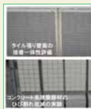
建築部材の品質向上に関する研究
