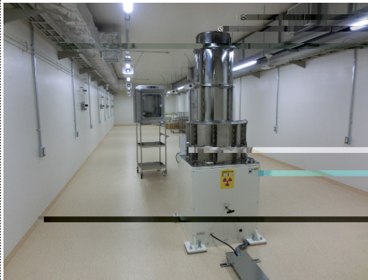
放射線先端医学実験棟1F 低線量率照射室
